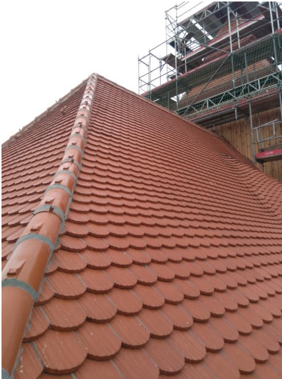
Bild 3: Grate mit Gratziegeln eingedeckt
