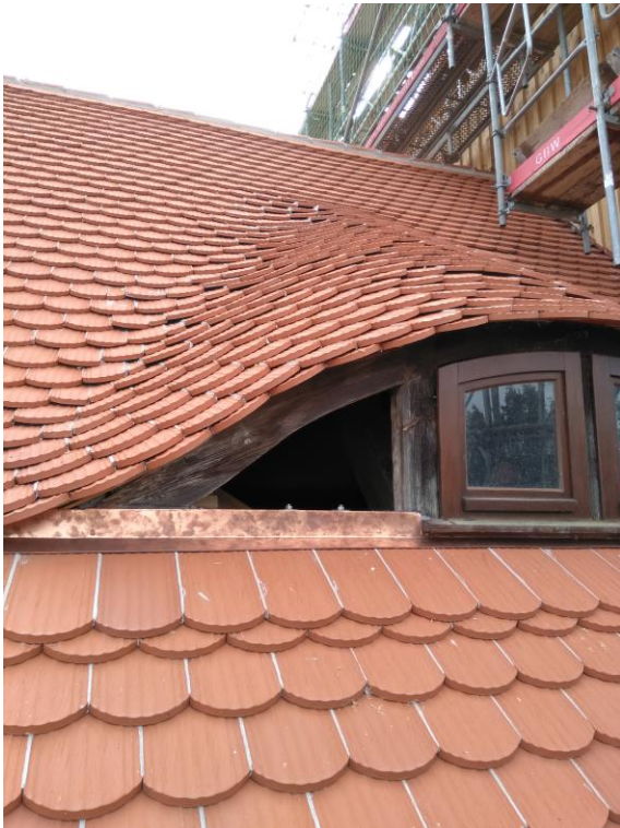
Bild 1: Dachdeckung Nordseite neu
