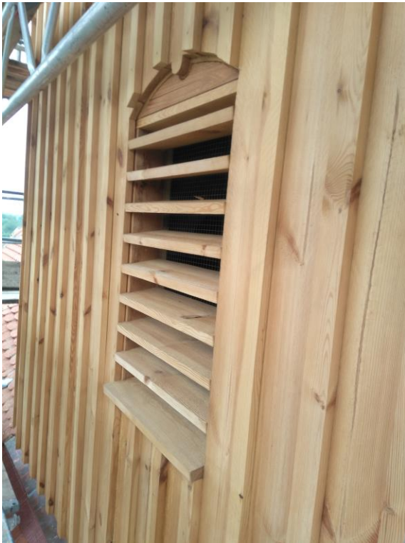
Bild 11: Turmverschalung mit Schalluken neu
