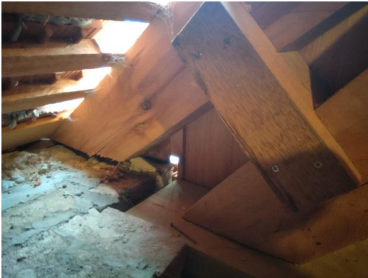
Bild 13: sanierter Fußpunkt mit Aufschiebling, luftumspült
