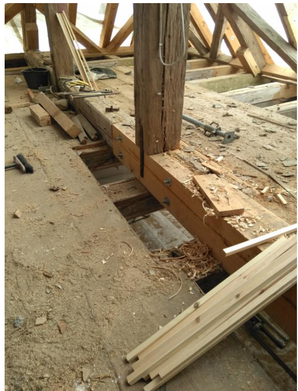
Bild 20: sanierter Überzug
