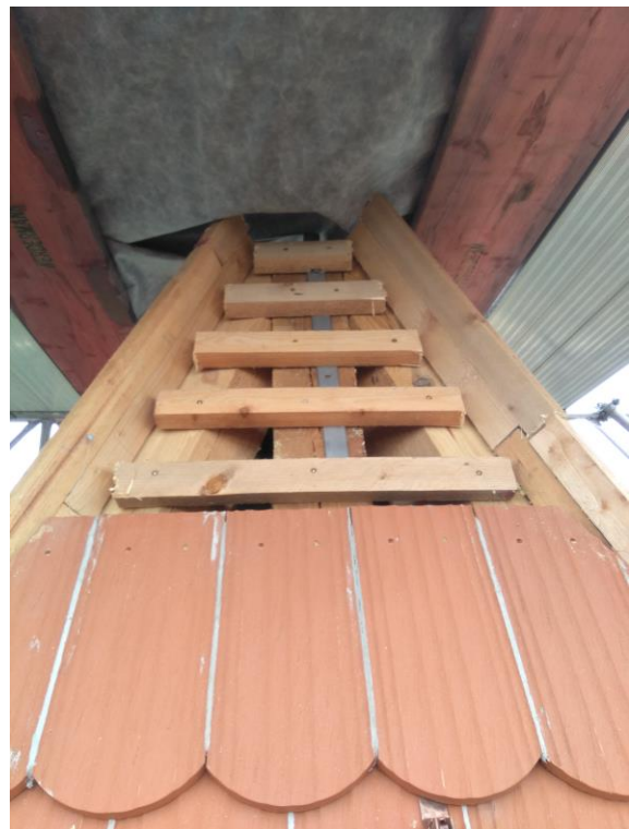
Bild 6: Eindeckung Turmdach
