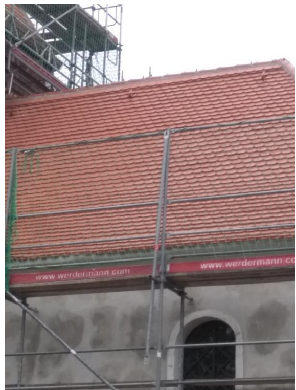
Bild 2: Dachdeckung Südseite neu
