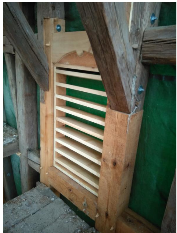
Bild 18: Einarbeitung Schallluken in Fachwerkfeld des Turmes
