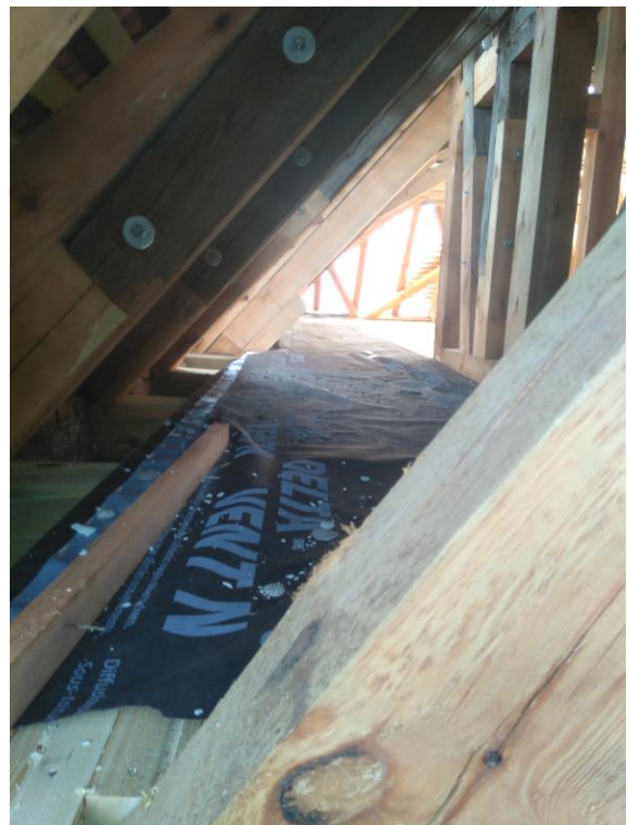
Bild 14: sanierter Bereich Blick von West nach Ost
