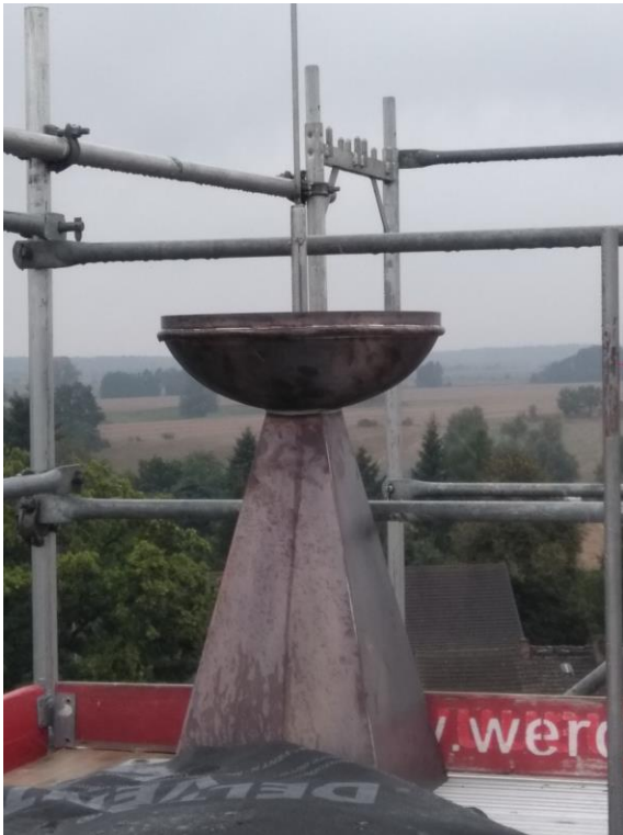
Bild 7: Bekrönung geliefert - Unterteil
