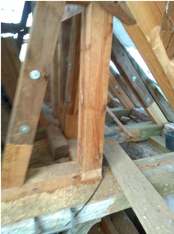
Bild 19: saniertes Turmfachwerk
