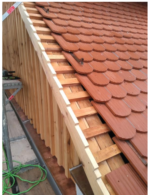
Bild 12: Turmverschalung neu mit Abtropfblechen und Zahnleiste
