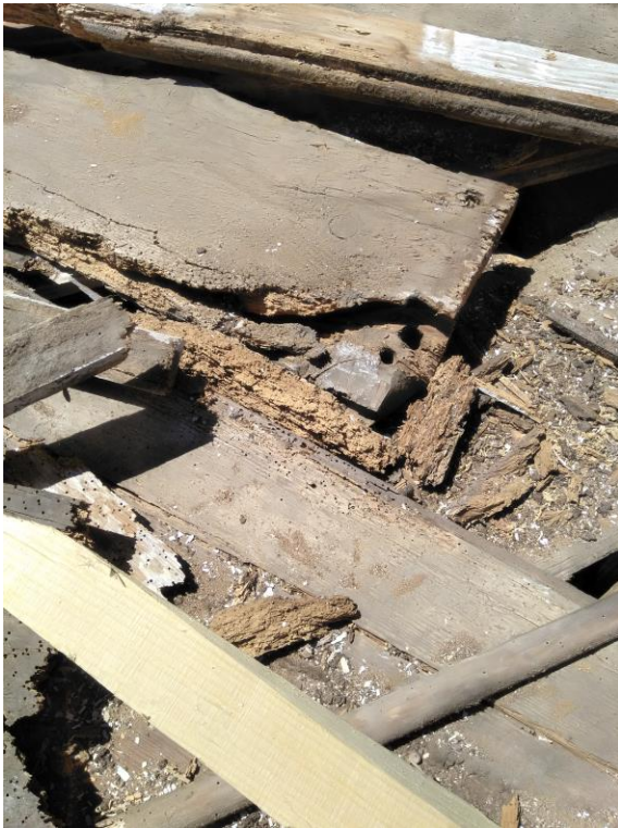
Bild 15: schadhafte Hölzer ausgebaut
