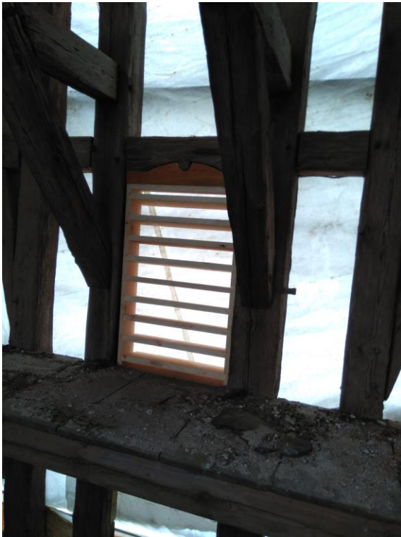
Bild 17: Einarbeitung Schallluken in Fachwerkfeld des Turmes
