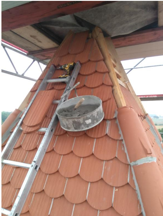
Bild 5: Eindeckung Turmdach bis in Spitze
