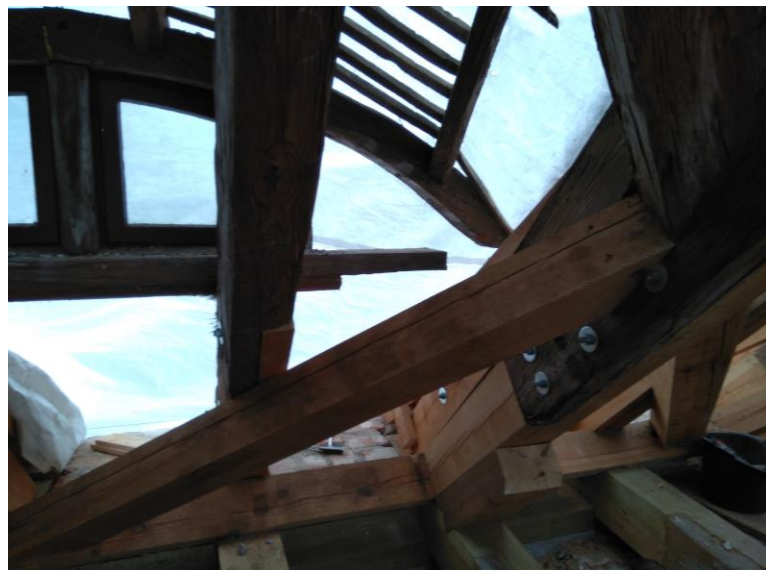
Bild 16: Aufarbeitung der Gaube
